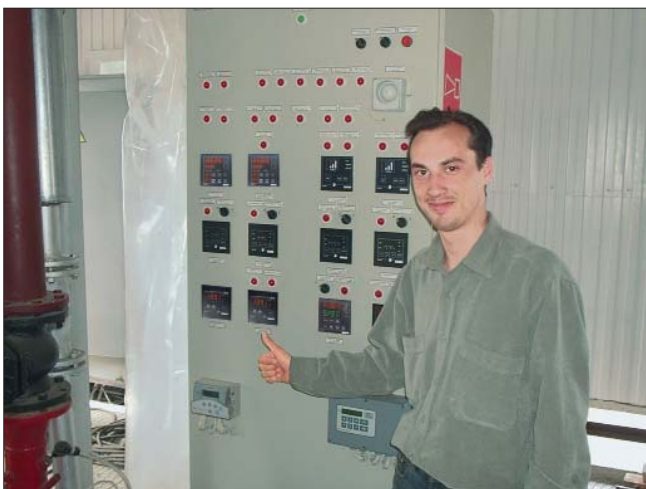
Фото 2. Владимир Жук – разработчик системы автоматической регистрации рабочих параметров процесса пастеризации на базе приборов ОВЕН
