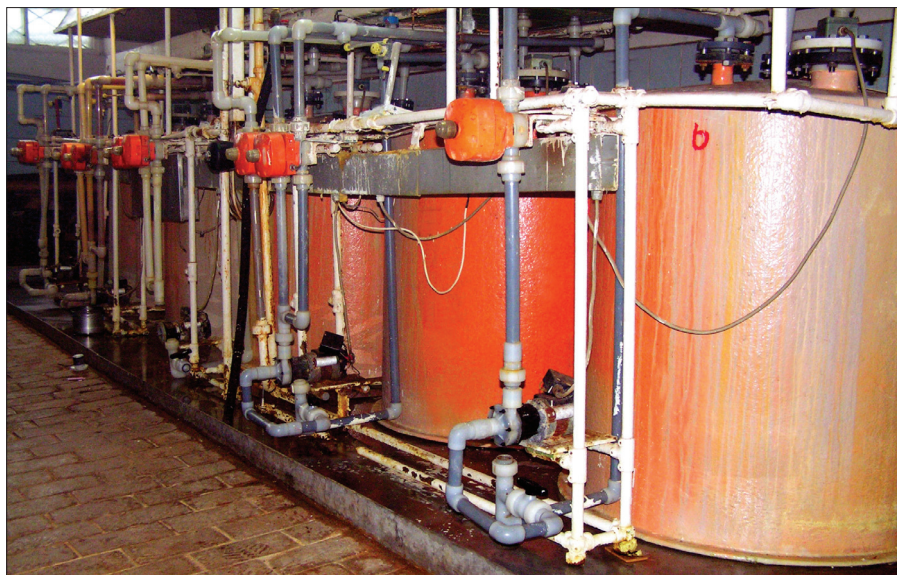
Фото 1. Емкости с реактивами на химическом участке завода КЭЛЗ
