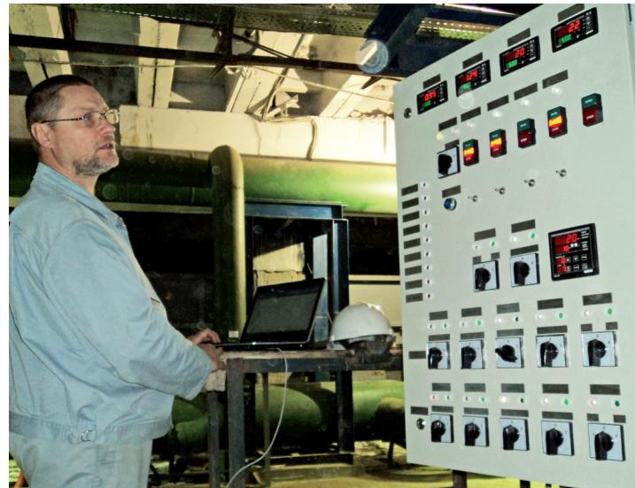
пульте тумблером. С его помощью можно не только включать или отключать насосы, но и выбирать необходимую производительность любого агрегата, используя встроенные потенциометры.
